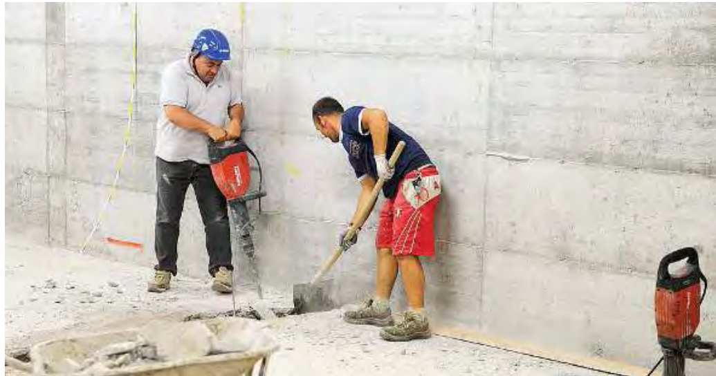
Si lavora all'interno dello stadio di Salò in vista della nuova stagione (Reporter Domini)
