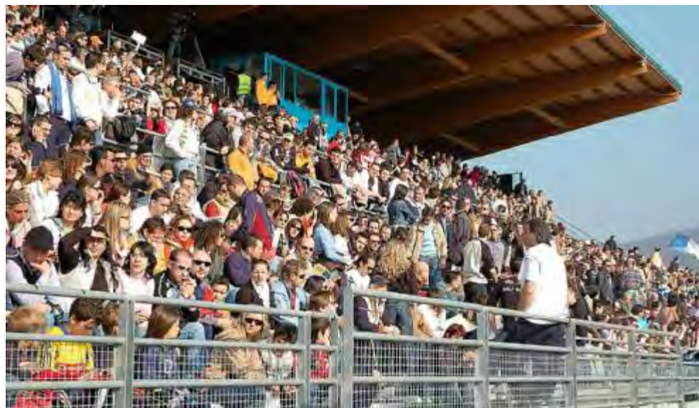
Le tribune dello stadio «Lino Turina»: il nodo dell'inadeguatezza dello stadio è finalmente risolto
