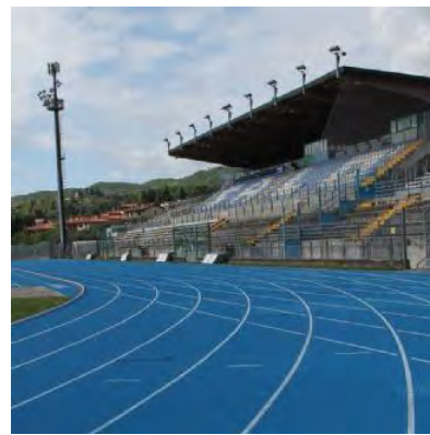
Prende forma il nuovo Turina: i lavori proseguono a ritmo serrato
